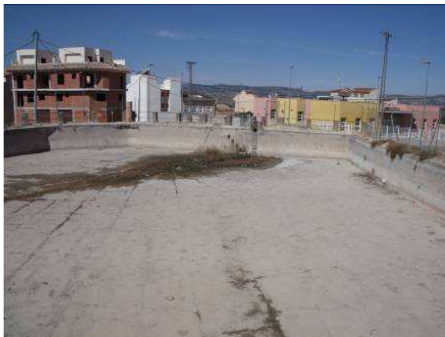
Figura 7. Balsa de acumulación de agua de Los Caños
